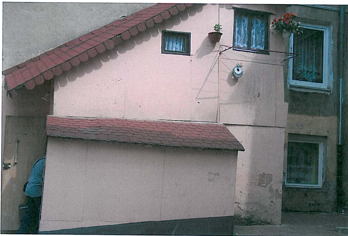
Fotografia nr 5. Widok obudowy schodów na elewacji południowej bocznej.
