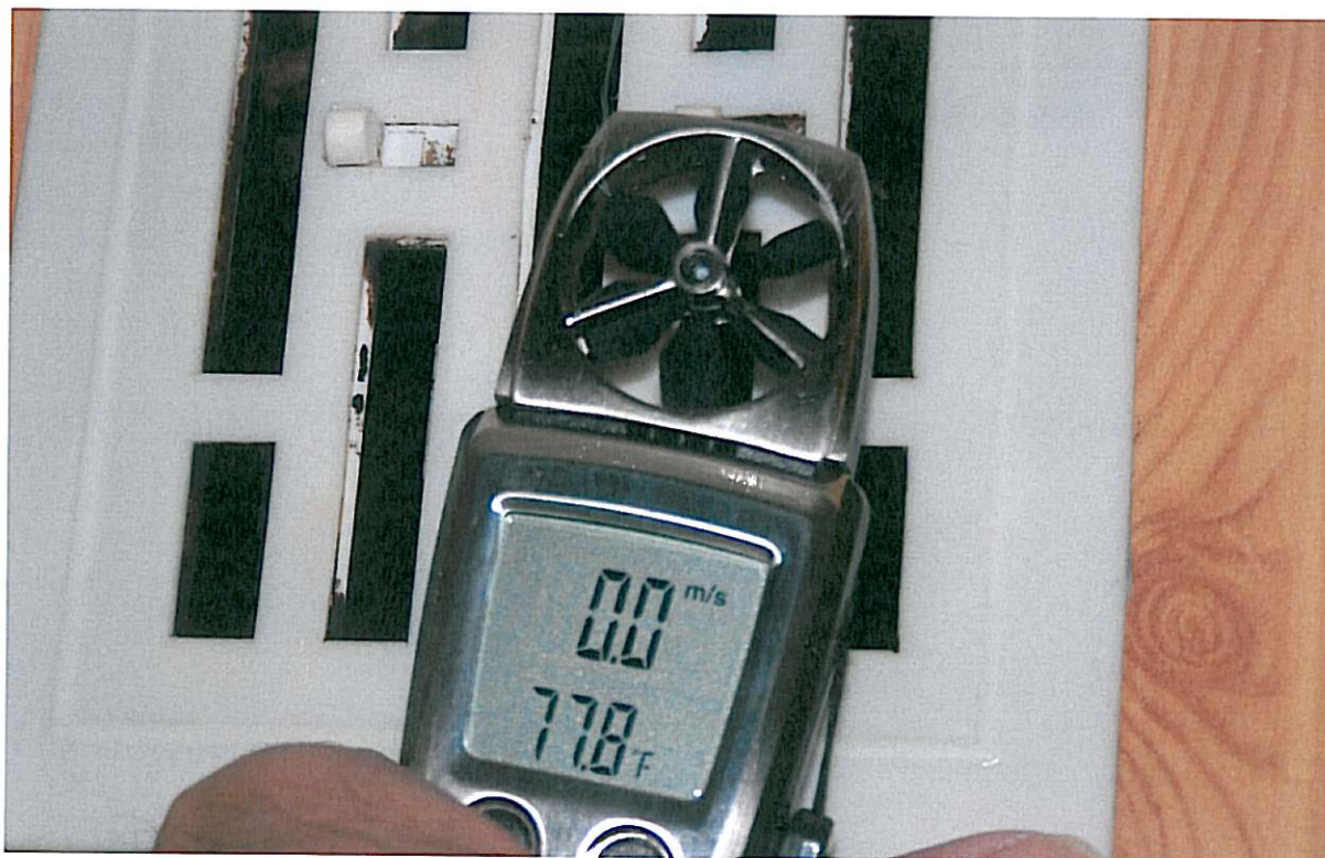
Fotografia nr 6. Pomiar strumienia wentylacyjnego w pomieszczeniu nr 0/19 załącz. nr 2.
