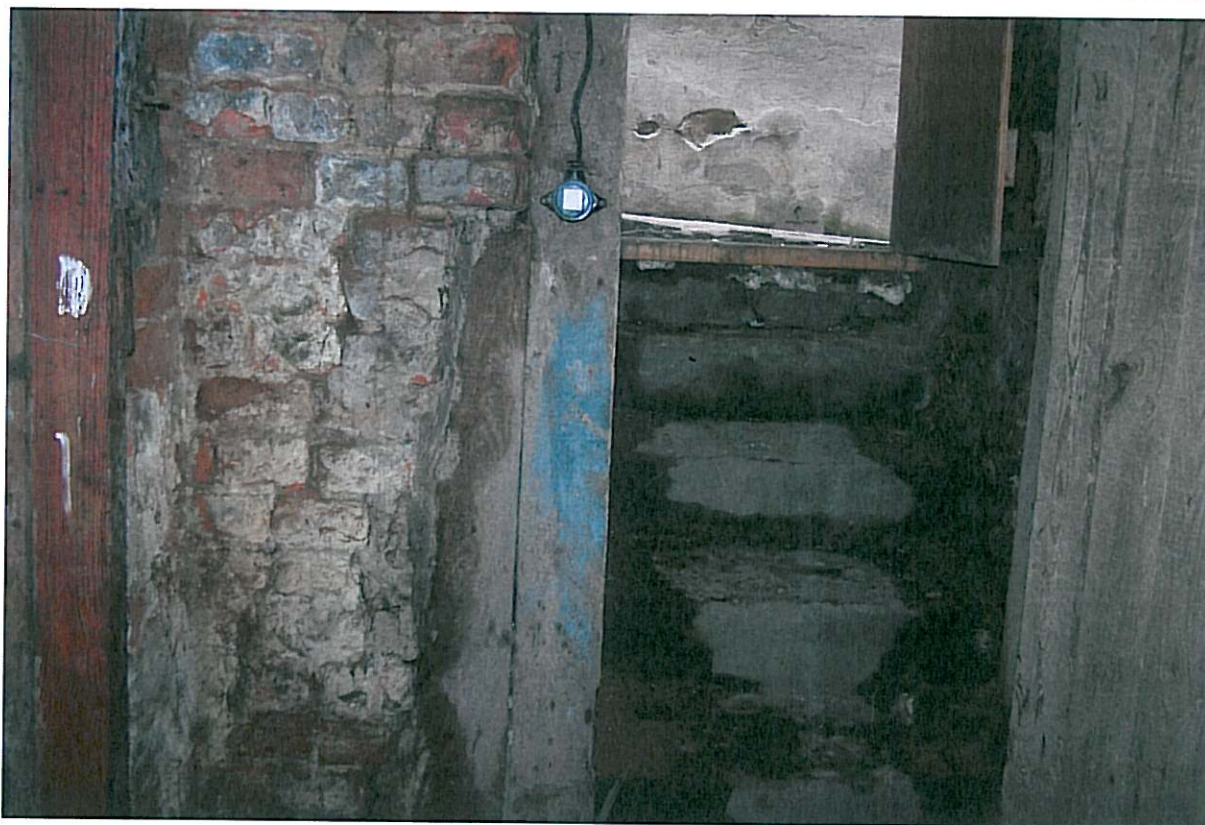
Fotografia nr 19. Pomieszczenie nr U/2 pokazane na rzucie w załączniku nr 1.
