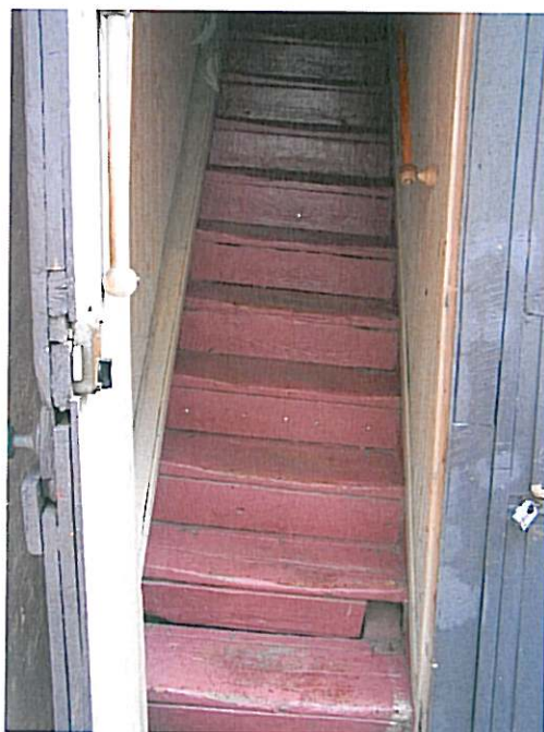
Fotografia nr 2. Schody do pomieszczenia 016 przedstawione na załączniku nr 2.
