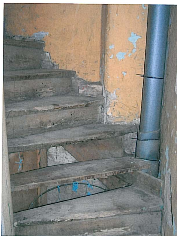
Fotografia nr 12. Schody z piętra na poddasze pomieszczenie nr s/1 pokazane na rzucie nr 4.
