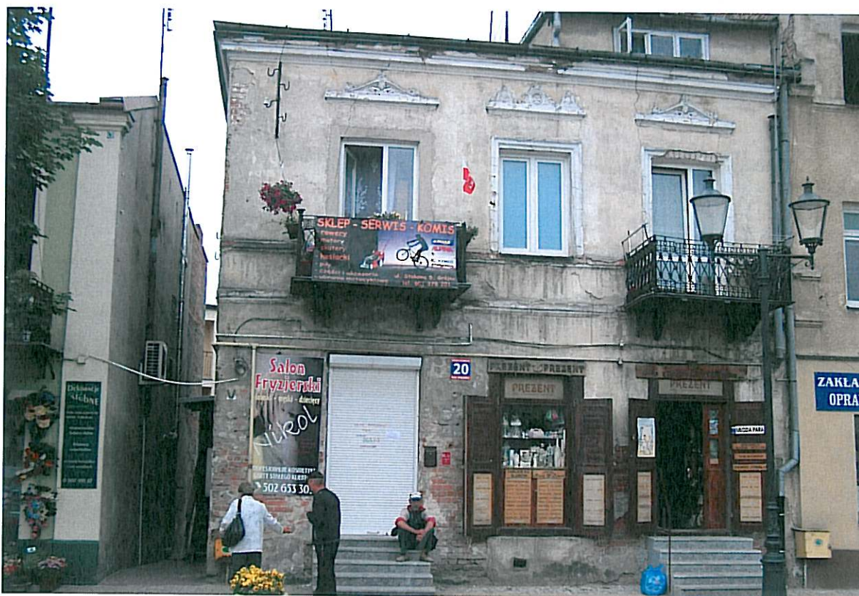
Fotografia nr 1. Elewacja wschodnia frontowa rzut przedstawiony w zał. nr 8.
